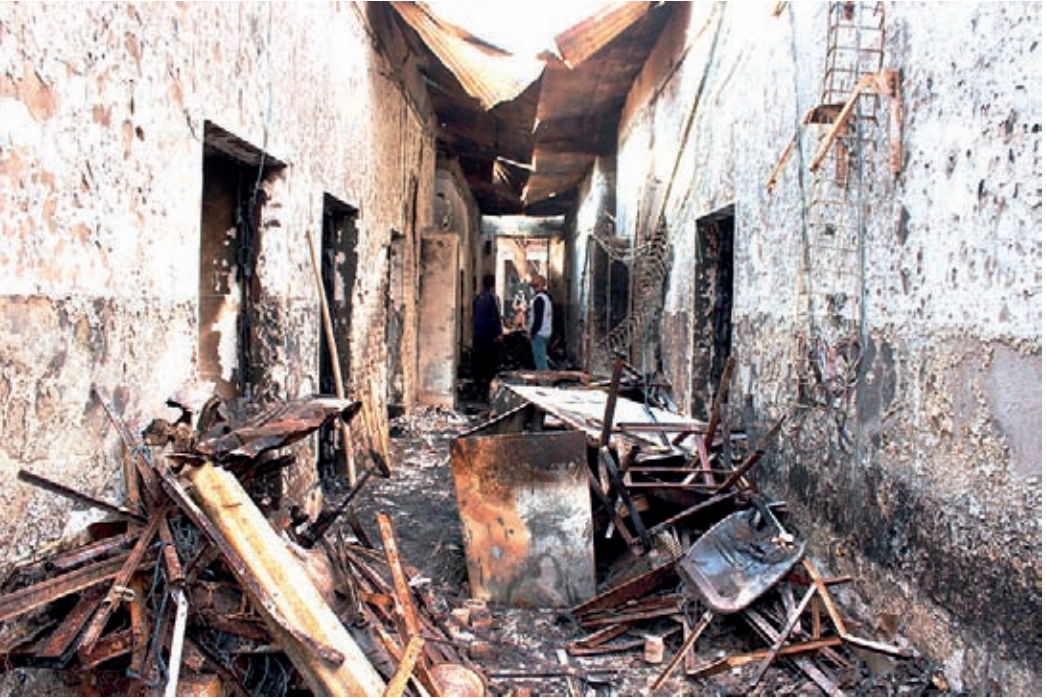
ภาพถ่ายเมื่อวันที่ 10 พ.ย. เผยให้เห็นสภาพความเสียหายภายในโรงพยาบาลของเอ็มเอสเอฟในเมืองคุนดุษ จากการโจมตีผิดพลาดของกองกำลังอเมริกันที่เข้าใจว่าอาคารหลังนี้ถูกกลุ่มตอลิบานควบคุมอยู่.
